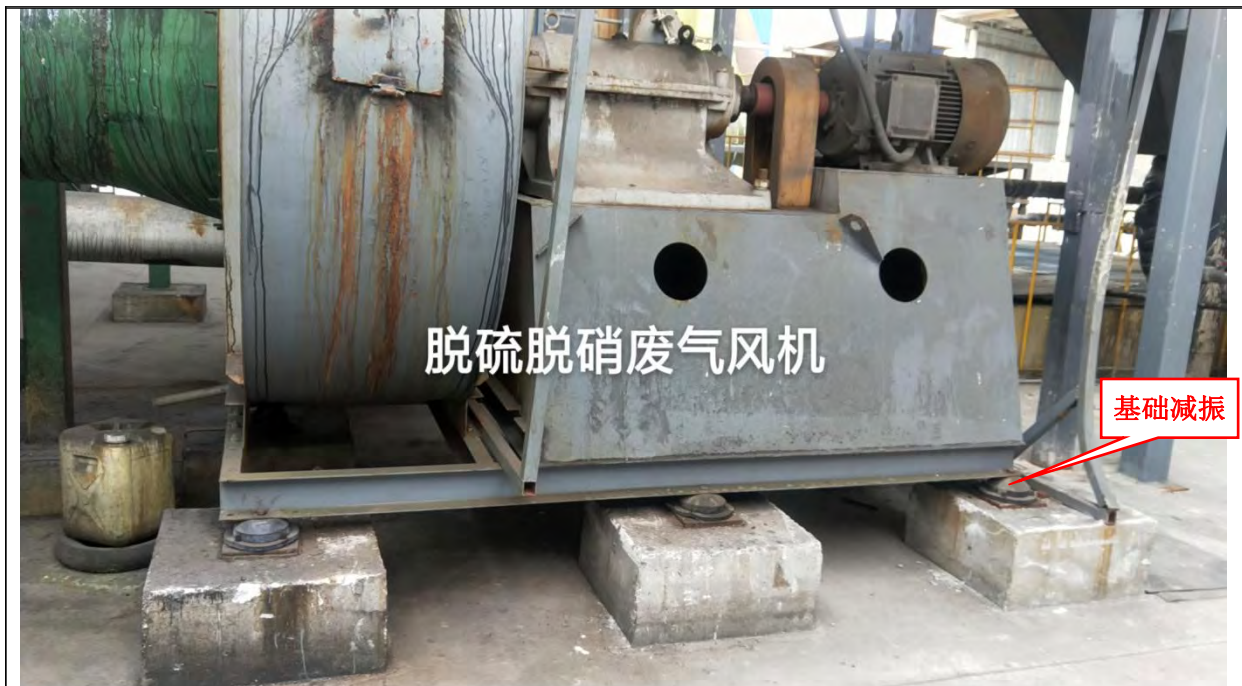
脱硫脱硝基础减振
